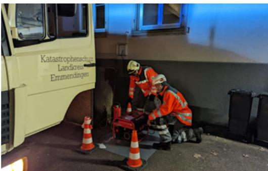
Funktionsüberprüfung der externen Notstromversorgung des Depots beim OV Kenzingen anlässlich des bundesweiten Warn-tags am 08.12.2022. Hierbei wurden die Diensträume über eine Außeneinspeisung
